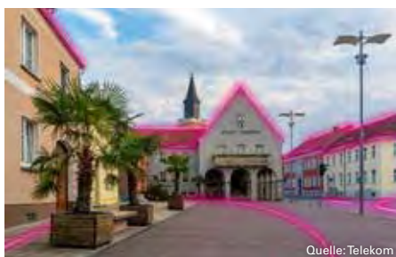
Für rund 3.100 Haushalte in Trebbin baut die Telekom Glasfaserleitungen aus.
