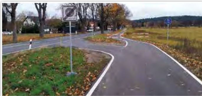
Tiefbau Radweg Schönhausen-Blankensee
