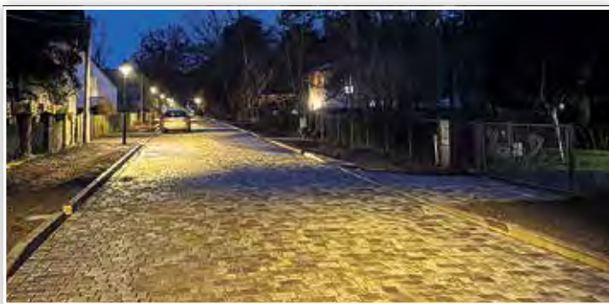
Tiefbau Ausbau Waldstraße
