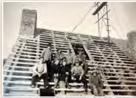
Wiederaufbau nach Bombenangriff im Jahr 1944
