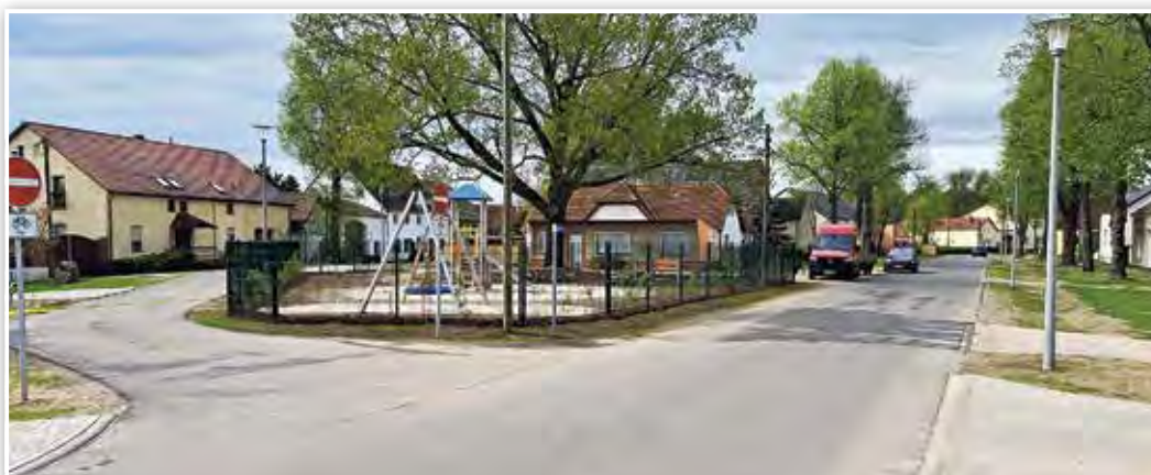
Die Straße „Dorfplatz“ fertig ausgebaut
