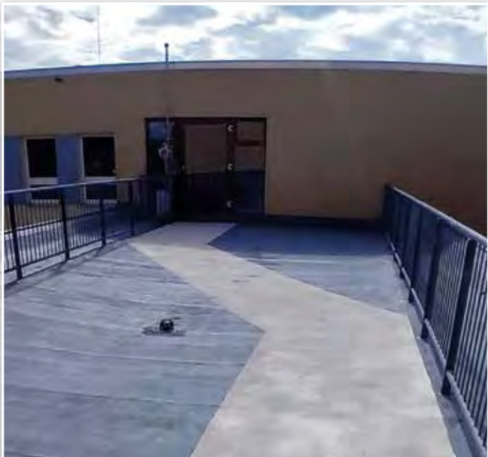
Das Dach mit Fluchtwegmarkierung
